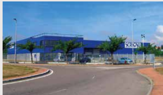
Scrigno France, sede di Montceau-les-Mines Factory in Montceau-les-Mines France
